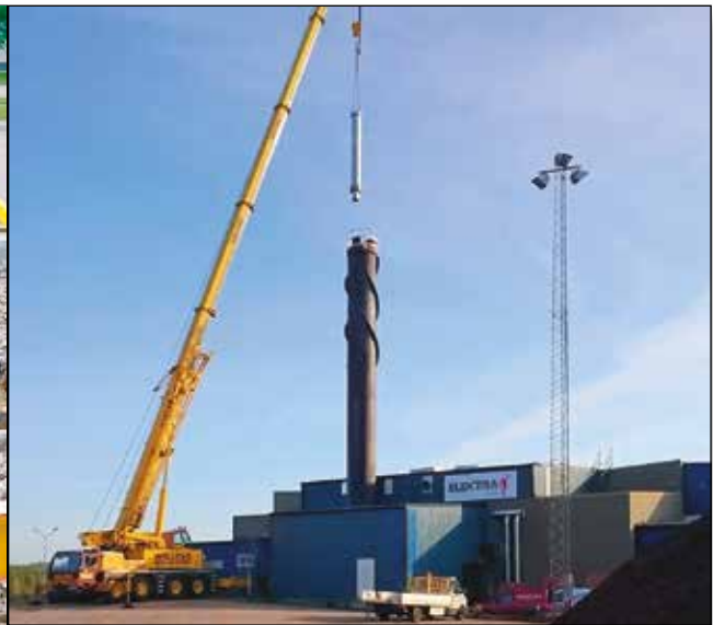
Modifiering av toppdelen på skorstenen vid pannan i Alfta. Detta efter problem med isbildning på gamla konstruktionen.
