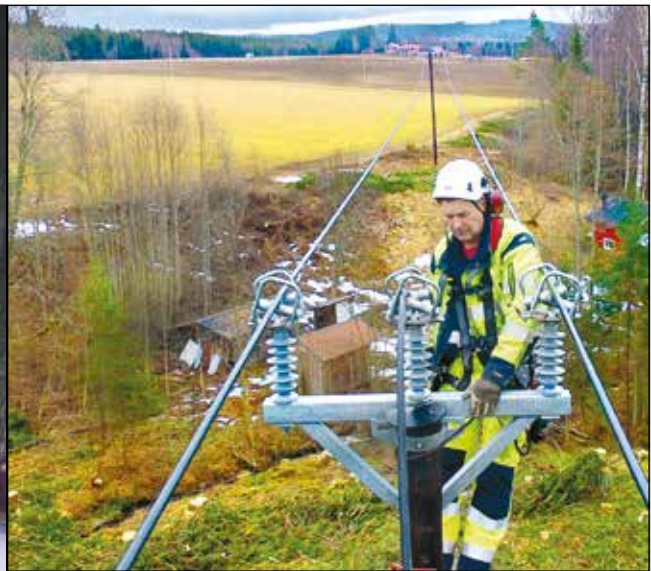
När nätbolaget nu är klar med ombyggnaden av Öjungslinjen så fortsätter man med att dra nya isolerade linor på Vallhagalinjen.
